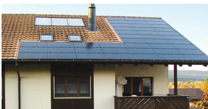
Plus de deux installations rectangulaires
