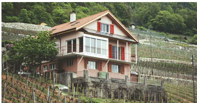
Installation en façade
