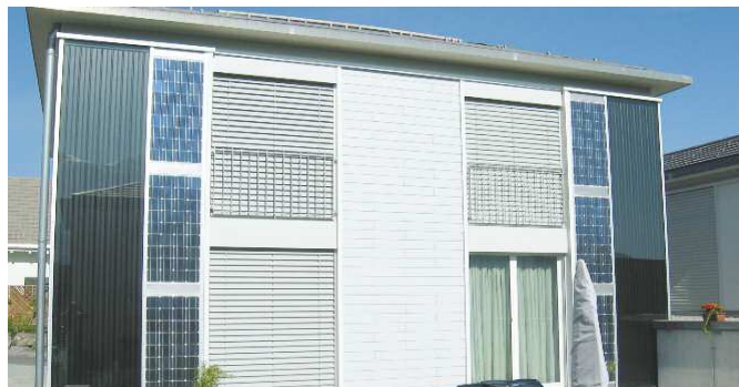
Installation en façade
