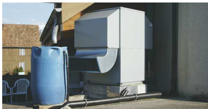
Pompe à chaleur air-air soumise à l'octroi d'un permis de construire (prélèvement de l'air à l'extérieur du bâtiment)
