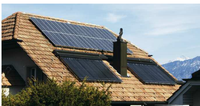
Plus de deux installations rectangulaires
