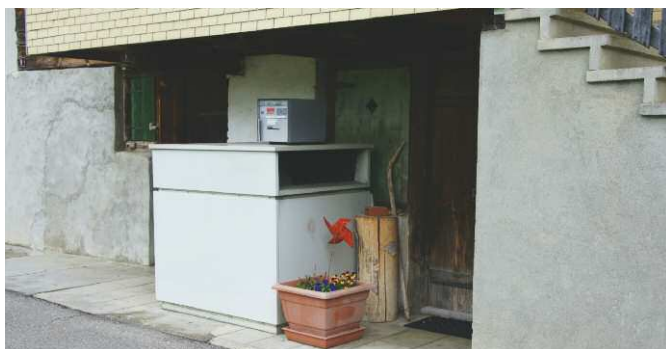
Pompe à chaleur air-air soumise à l'octroi d'un permis de construire (prélèvement de l'air à l'extérieur du bâtiment)
