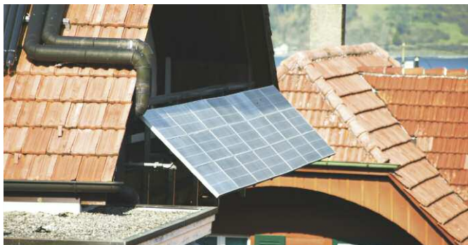
Installation en façade
