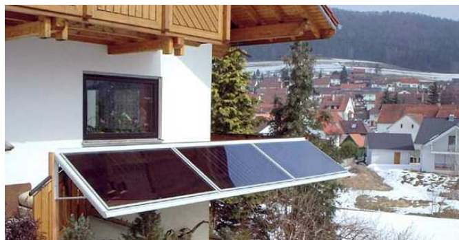
Installation en façade
