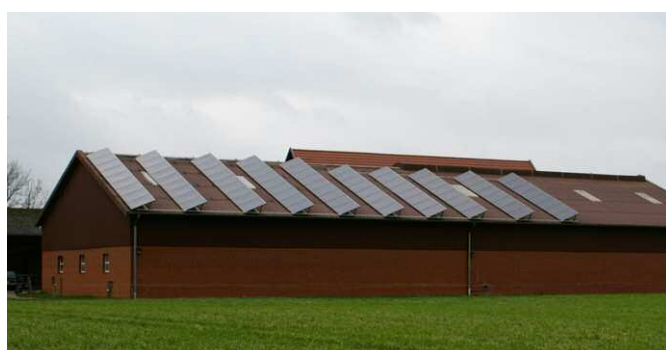
Installation fixée sur un support incliné (&gt; 20 cm)
